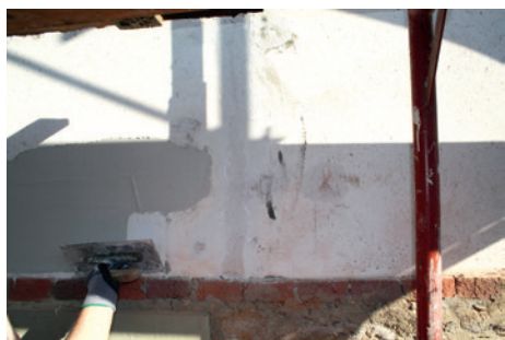
Zum Schließen von Rissen und Ausgleichen von Putzunebenheiten
