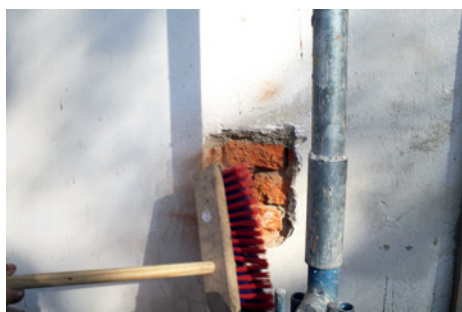
Putzfehlstellen reinigen
