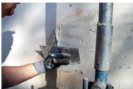
Ausputzen der Fehlstellen mit Baunit MultiWhite | RenovierSpachtel W
