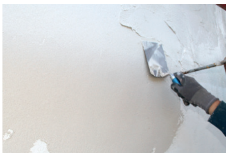
Strukturieren der Putzoberfläche
