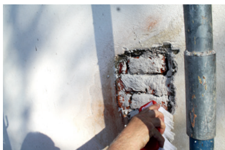
Vorspritzen auf vorgehässigten Untergrund mit Baunit MultiWhite | RenovierSpachtel W
