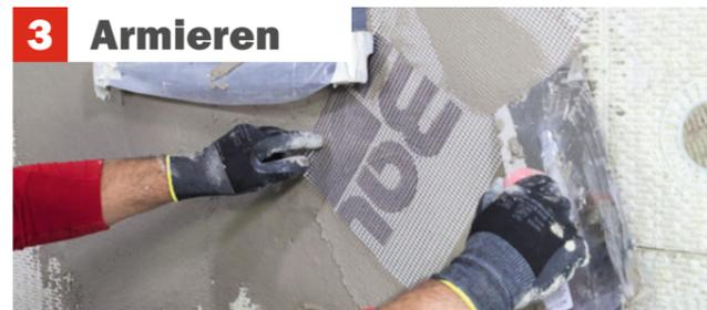
In allen Eckbereichen von Gebäudeöffnungen werden Diagonalarmierungen eingesetzt, um den grösstmöglichen Schutz vor Kerbrissen zu bieten. An Aussenecken werden PVC-Eckwinkel in den Armierungskleber eingespachtelt. Anschliessend flächig das Armierungsgewebe einspachteln, bis dieses nicht mehr zu sehen ist.
