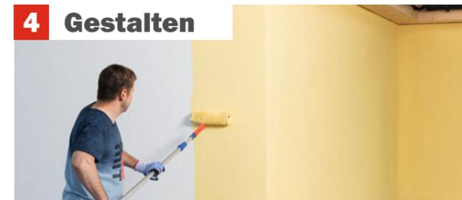
Zunächst wird die Fläche grundiert. Anschliessend trägst du deine gewünschte Baumit Endbeschichtung auf.
