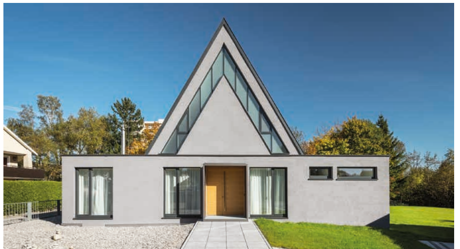
Kirchengumnutzung in Wohnhaus, Kaufbeuren
