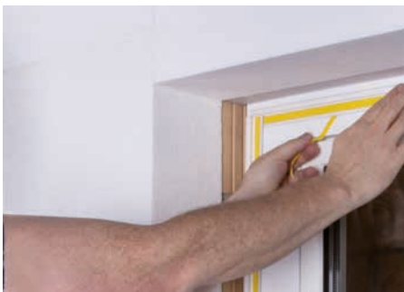
Ankleben des Anschlussprofils. Der vordere Schenkel muss bündig zur Vorderkante des Bordprofils der Fensterbank ausgerichtet werden.
