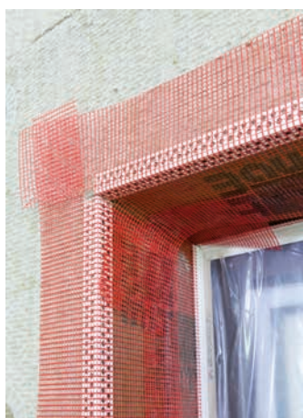
Es ist auf eine ausreichende Überlappung des Gewebes in den Eckbereichen der Laibung zu achten.
