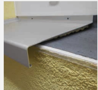
Fensterbank mit zweiter Dichtebene
