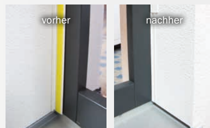
Die Anschlussprofile sind überstreichbar.
