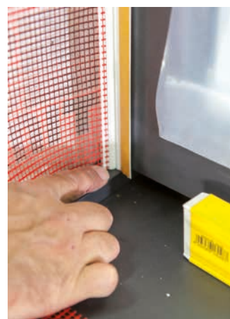
Die Positionierung der Anputzleisten hat so zu erfolgen, dass die fertige Putzoberfläche mit dem Bordprofil bündig abschließt.
