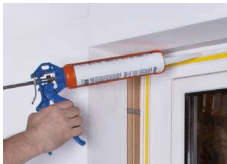
Auftragen des Baunit MontageKlebers im Anschlussprofil.
