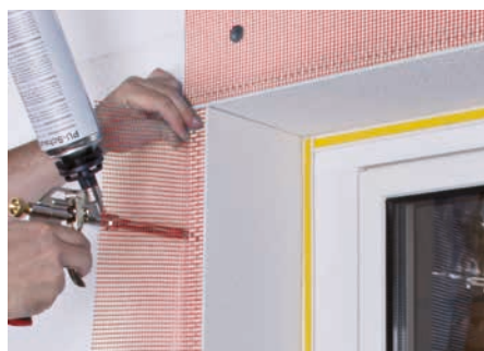
Das Laibungselement leicht wegklappen und mit Baunit easy pro KlebeSchaum hinterschäumen.
