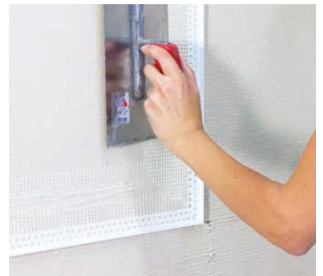
Das lot- und fluchtgerecht ausgerichtete Profil wird in den Klebspachtel eingebettet.
