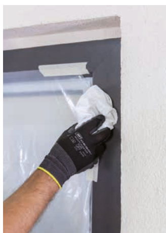
Vor dem Ankleben der Anputzleisten muss der Untergrund gründlich gereinigt werden.
