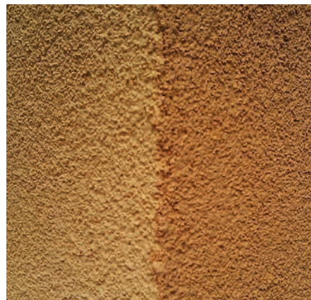
Farbtonunterschied verursacht durch verschiedene Chargen aus unterschiedlichen Tinting-Anlagen
