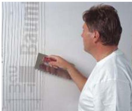
Bei Bedarf kann eine zweite Lage Armierungsspachtel nach dem Ansteifen in einer maximalen Schichtstärke von 2 mm über die im ersten Arbeitsgang aufgetragene Armierungslage aufgezogen werden. Diese Vorgehensweise entspricht den nach DIN 18345 geforderten, gesonderten Maßnahmen für Oberputze bei kleineren Körnungen als 3 mm.
