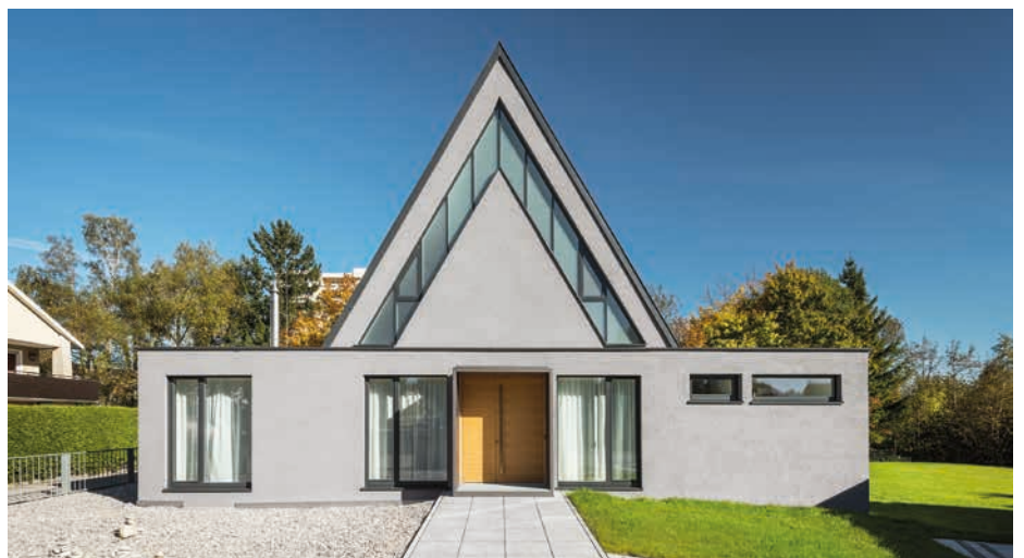
Kirchenumnutzung in Wohnhaus, Kaufbeuren
