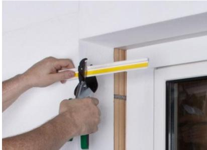
Es ist ein spannungsfreier Einbau des Anschlussprofils zu gewährleisten. Um Verformungen durch thermische Einflüsse aufnehmen zu können, ist auf beiden Seiten ein Mindestabstand von 2 mm einzuhalten.
