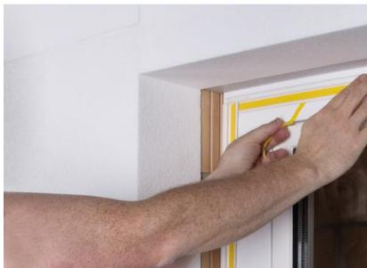
Die Klebeflächen müssen sauber und trocken sein. Der vordere Schenkel muss bündig zur Vorderkante des Bordprofils der Fensterbank ausgerichtet werden.
