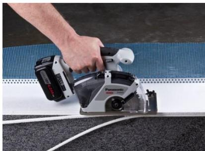
7. Bei den Anschlussprofilen U-DA und L muss mit dem Nuthobel eine Nut in das Laibungselement geschnitten werden
