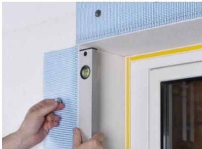
12. Die Fugen im Eckbereich zwischen Sturz- und Laibungsplatten sowie zum Bordprofil mit Baunit MontageKleber ausfügen
