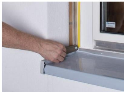
Die Breite ermittelt sich aus dem Abstand der Innenseite des Anschlussprofils und der späteren Armierungsputzschicht.
