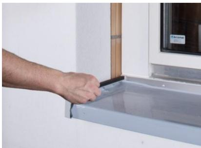
Die Klebeflächen müssen sauber und trocken sein. Das Fugendichtband muss ca. 3 mm von der Vorderkante des Laibungselements zurückgesetzt aufgeklebt werden, damit der Anschluss später verfugt werden kann.
