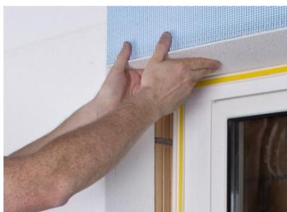
Zuerst das Sturzelement, anschließend die Seitenelemente einbauen.
