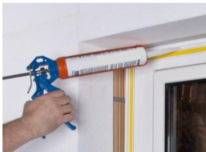
Der MontageKleber muss in die zur Laibung zeigenden hinteren Ecke des Anschlussprofils aufgetragen werden.
