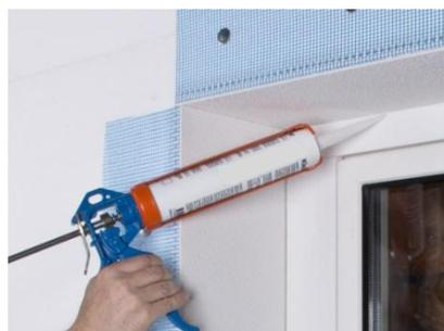
Bei dem Anschlussprofil L sind die Fugen zwischen Laibungselement und dem Fenster- oder Türrahmen ebenfalls auszufügen.
