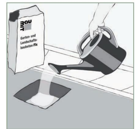
3 Das Material gut durchnässen. Nach ca. 3 Minuten kann die nächste Lage Material (10 cm) eingebracht werden.
